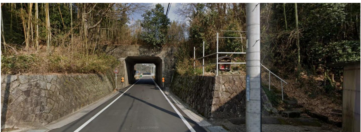
上 天井川トンネルの位置 大津市羽栗3丁目 県道 108 号
