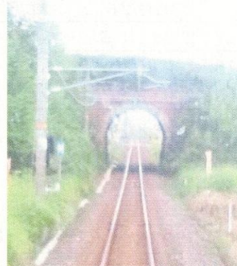
草津線 大砂川トンネル （電車の運転席より撮影）
