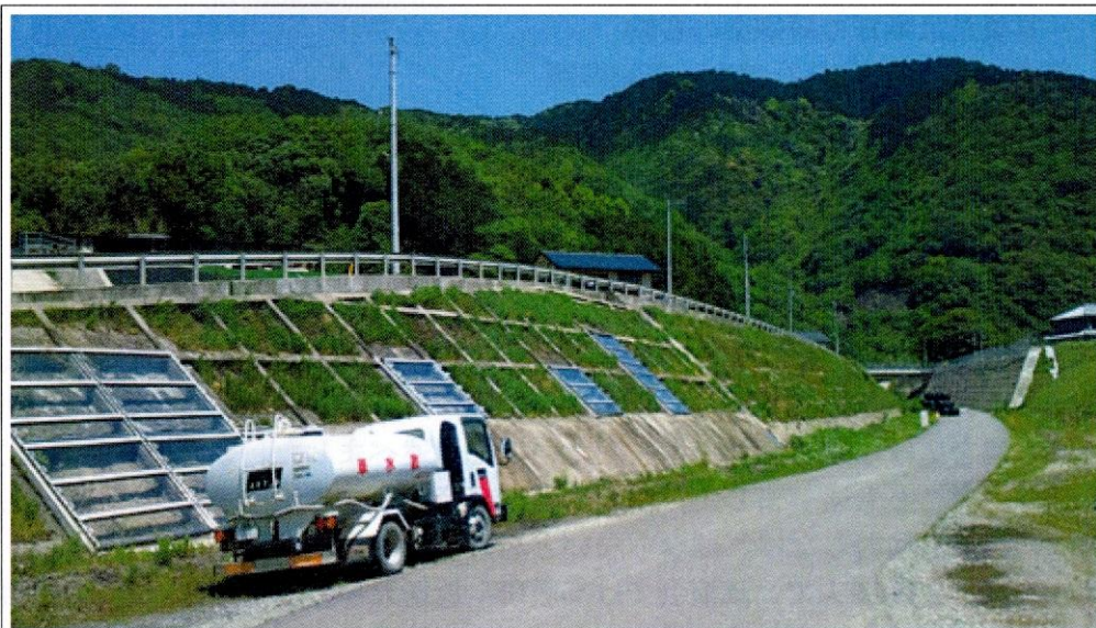
猪ノ鼻道路の中央構造線露頭（三好市州津）
