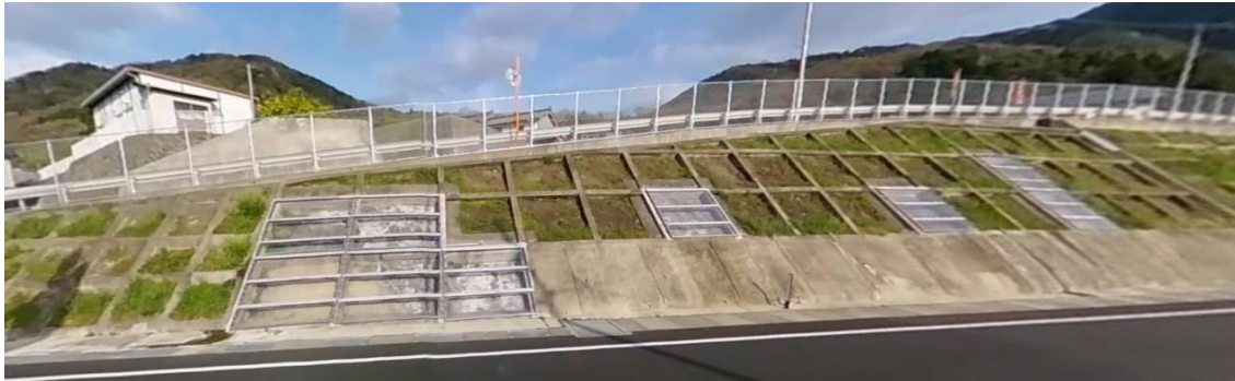
国道 32 号の側壁に見られる中央構造線断層露頭
