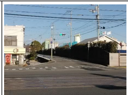
中堤(棧橋4丁目電停) 見よ、低地との高低差！
