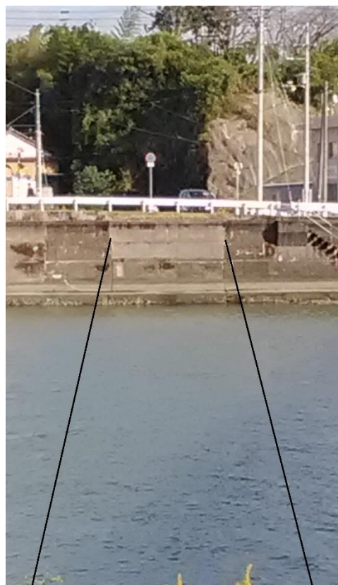
旧橋撤去後 2021 年撮影 コンクリートの色の違いが分かる
