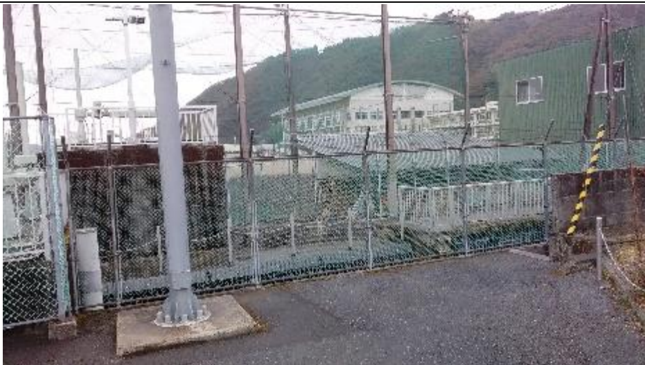
吸・排水口を東から眺める(2022/2/19 南寿宏撮影) 奥は高知県立伊野商業高等学校
