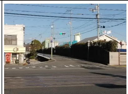
中堤(棧橋4丁目電停) 見よ、低地との高低差を！
